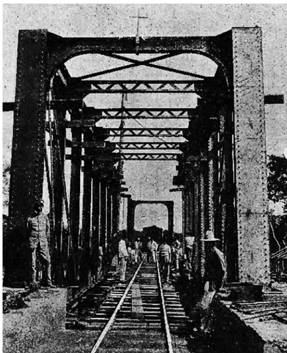
Figura 2: Trabalhadores constroem a ponte sobre o Rio Bicudo, provavelmente em 1907. Fonte: FIGUEIRA, p. 788, 1908.
